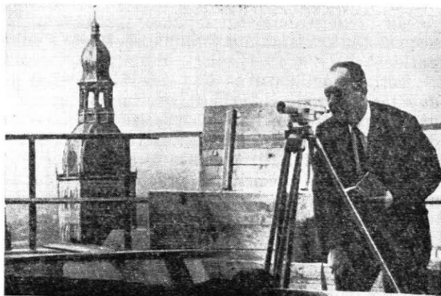
4. att. Veidņu līmetņošana 47,4 metru augstumā. Pie niveliera J. Klētnieks. Attēla kreisajā pusē redzams Doma baznīcas tornis. (E. Darbvara fotouzņēmums.)
