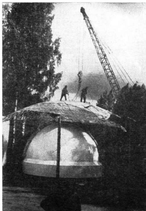
2. att. Uz montāžas stenda samontēts pirmais stiklaplasta kupols.
