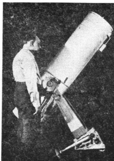
3. att. S. Bohanovs pie pašbūvētā 315 mm Kasegrēna teleskopa.
