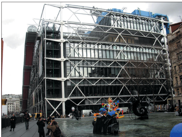
6. att. Pompidou izstāžu komplekss atgādina ēku ar stalažām, jo komunikācijas, ūdensvads utt. izvietoti caurulēs uz celtnes fasādes.
