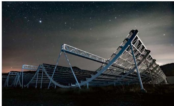
Radioteleskops CHIME sastāv no četrām 100 × 20 metrus lielām puscilindriskas formas antenām
