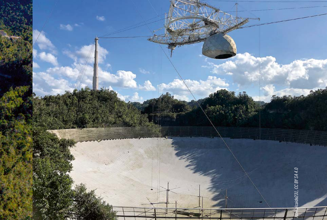
Aresibo radioteleskopa galvenais reflektors un trosēs iekārtā instrumentu platforma
